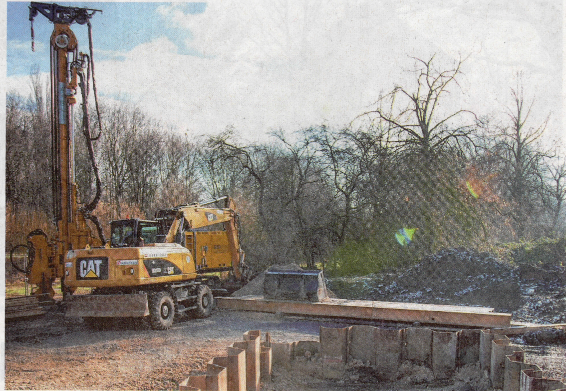
An der Straße Im Osterbruch haben die Stadtwerke bereits einen Schacht angelegt, durch den das Grundwasser sechs Meter in die Höhe gepumpt werden soll. Vor dem Kanalbau musste viel vorbereitet werden.
