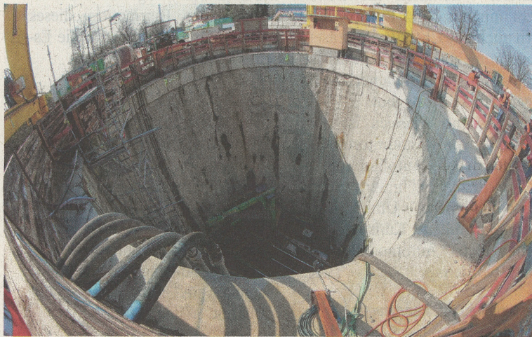
Das „Karnaper Loch“ ist 24 Meter tief und hat einen Durchmesser von 15 Metern. Ende 2016 soll es mit einem Betondeckel verschlossen werden.
