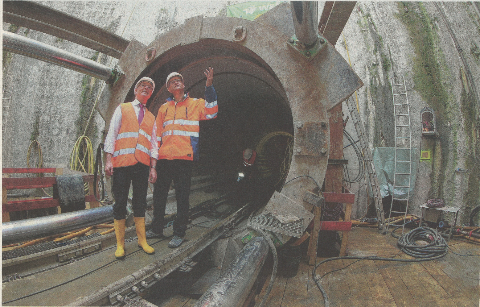
Oberbürgermeister Reinhard Paß (links) besichtigt mit Projektleiter Christian Strasser den zukünftigen Emscher-Kanal in Karnap.
